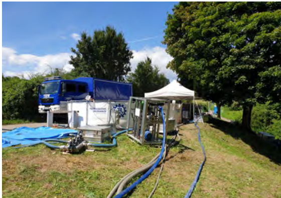
Wasseraufbereitung für den Ortsteil Wangen
