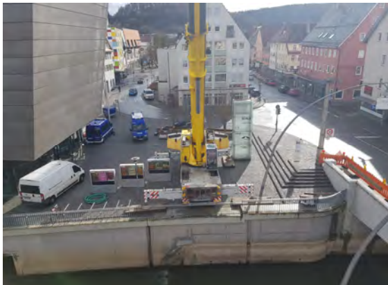
Stromversorgung und Pumparbeiten in Tuttingen
