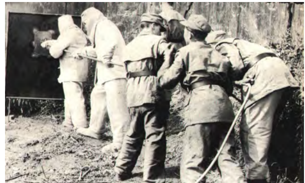
Bild links: Auf dem Gelände der alten Unterkunft am See erproben die Helfer des THW-Ortsverbands Radolfzell die Sauerstoffflanze. Im Hintergrund der Neubau des späteren Reitstalls und des „Bodenseereiters“.
