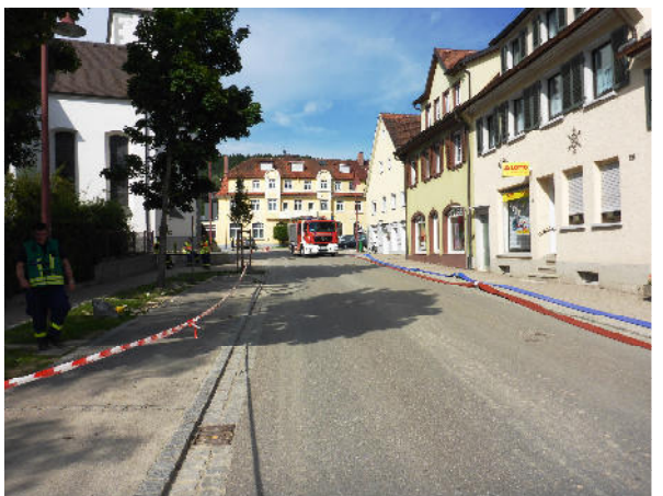
Zwei Schlauchleitungen durchqueren den Ort bis zur Wassereinlaufstelle
