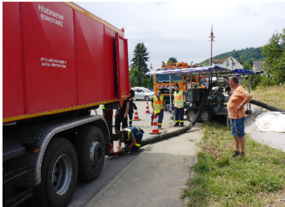
Die Hannibal-Pumpe im Einsatz. Die Schlauchverlegung übernimmt hier die Feuerwehr Konstanz
