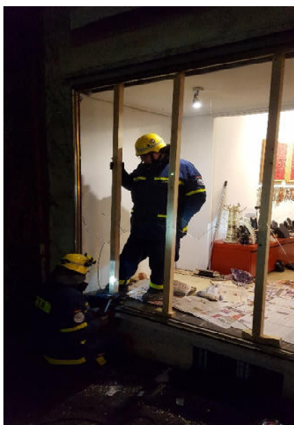
Beschädigtes Schaufenster beim Juwelier Radolfzell
